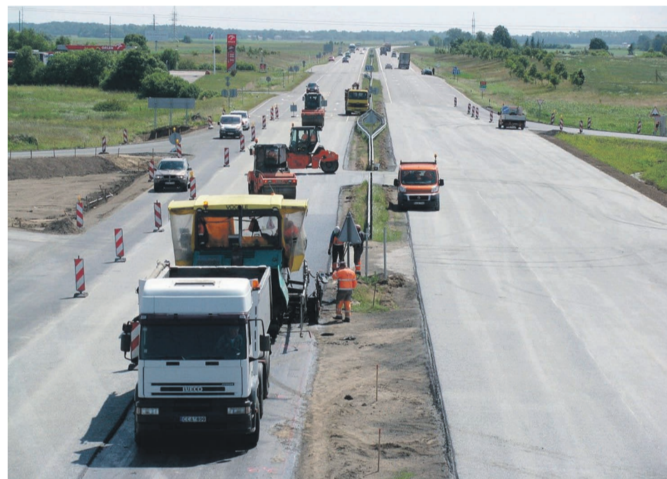
Palangas apvedceļa būvniecība.
